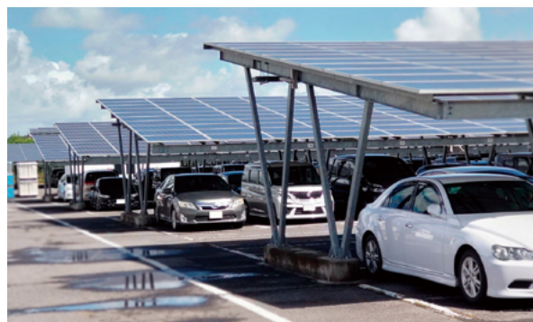
工場の駐車場に庇を兼ねたソーラーパネルを設置、PV発電電力の自家消費と舗装の温度上昇を低減
