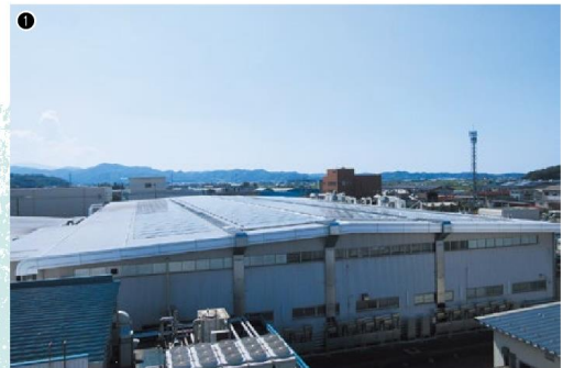
① 工場の屋根上などへ太陽光発電設備を設置 ② 太陽光カーポートも採用
