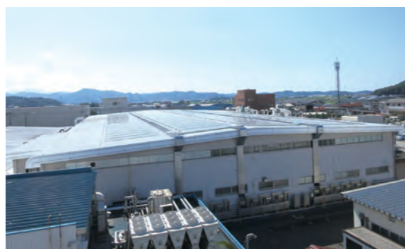
工場屋根にソーラーパネル+自社製パワーコンディショナを設置、電力使用量を削減
